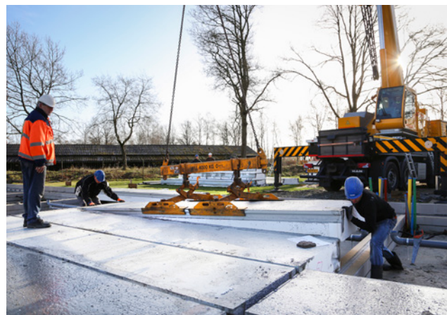
DE VLOER VOOR DE BEGANEGROND WORD GELEGD
